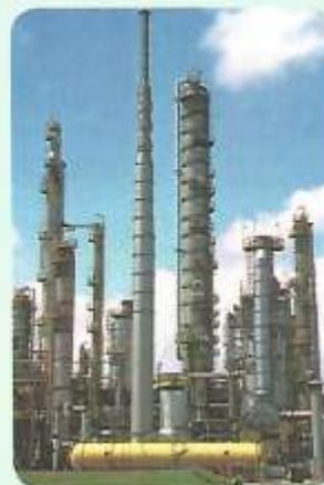
▲ Torres de fracionamento de petróleo. A destilação fracionada baseia-se na diferença de volatilidade entre os vários componentes do petróleo. Mauá, SP, 1996.
